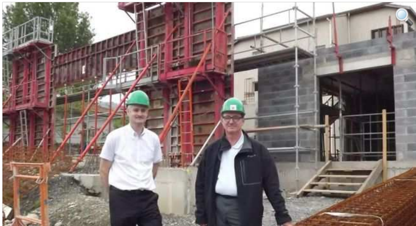
Alain Esquerre, le directeur, sur le chantier avec Gilbert Julia, le maire de Loures Barousse./Photo DDM, C. T
